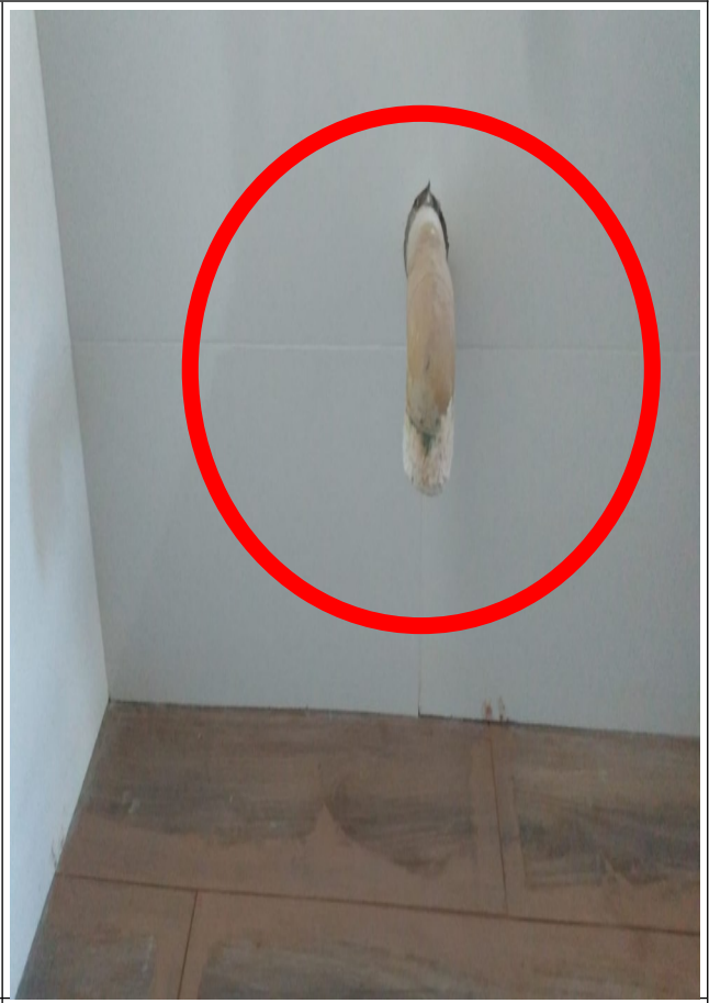
Imagem 02 – local saída de vapor sauna.
