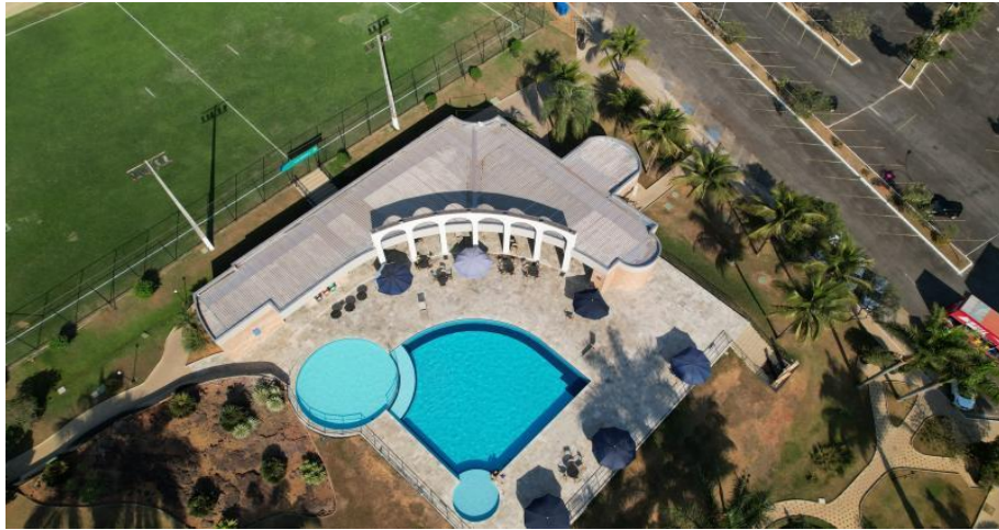
Figura 1 – Imagem do telhado existente do Pier.
